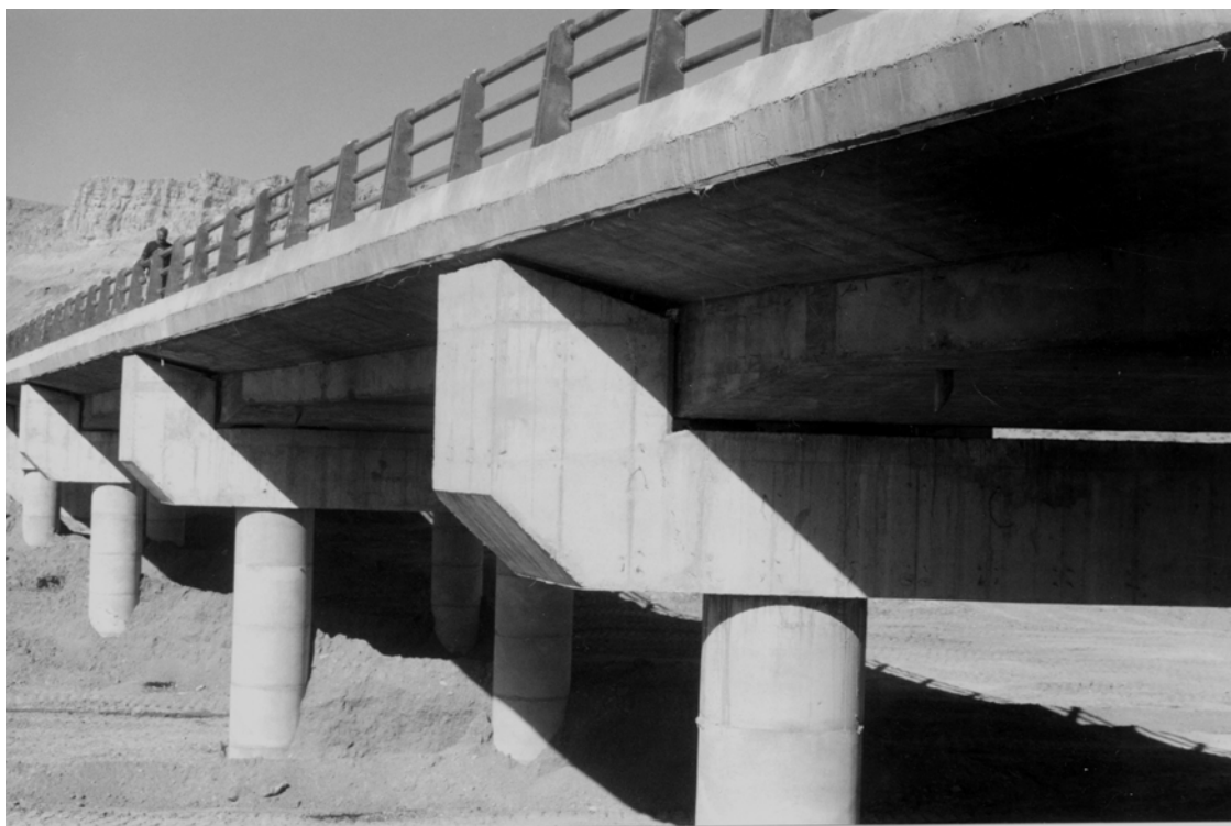
پل هستیجان یک
